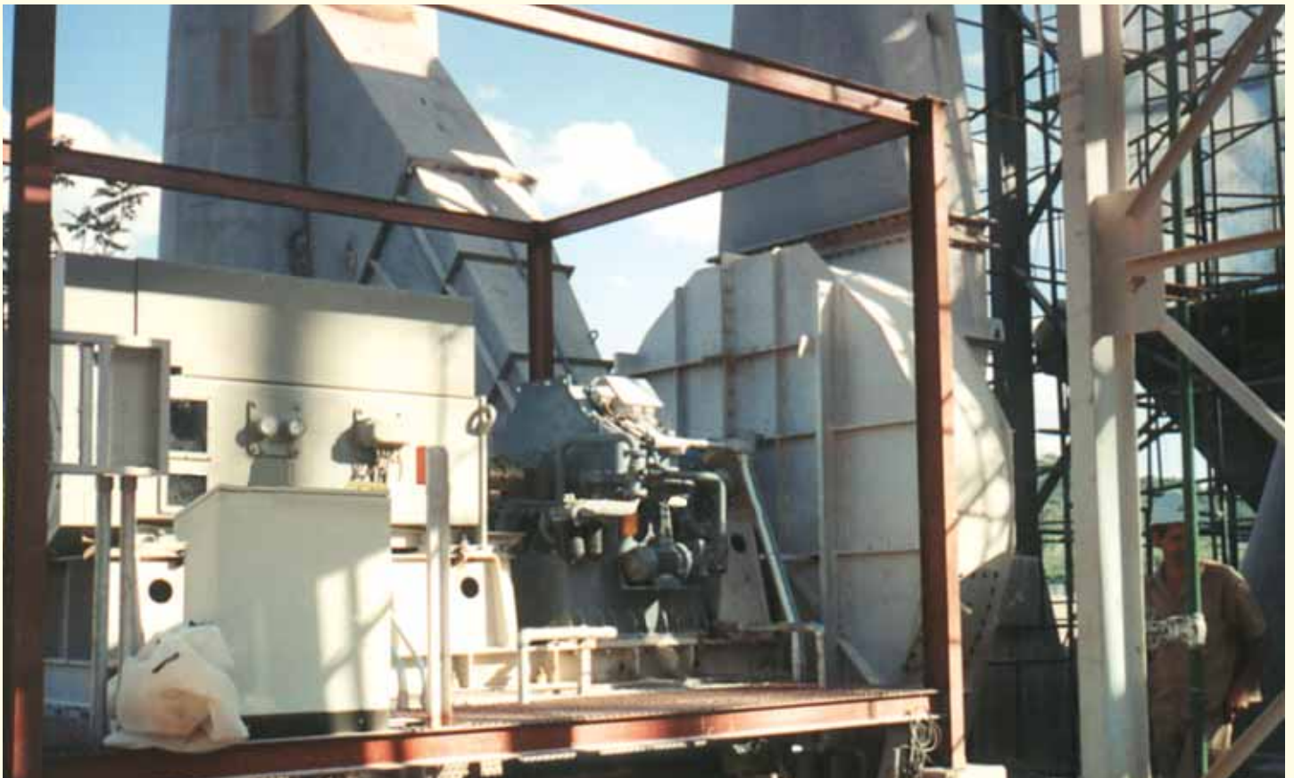
34 KSL, 700 кВт - 1200 об/мин. Вентилятор с регулируемой скоростью (Бразилия)
